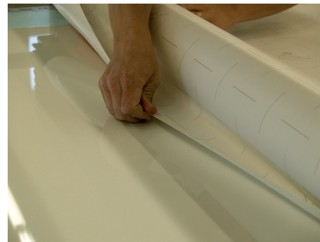
11. Agarrar la parte del revestimiento doblado debajo del rodillo ...
