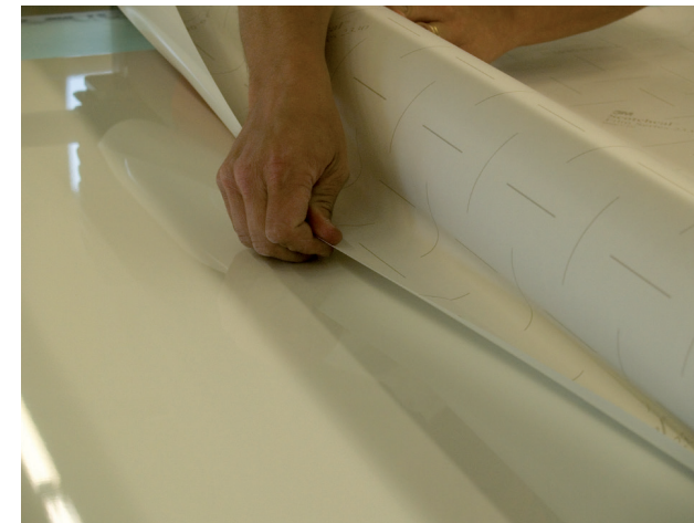
11. Ziehen Sie die eingesteckte Schutzfolie unter der Walze hervor ...
